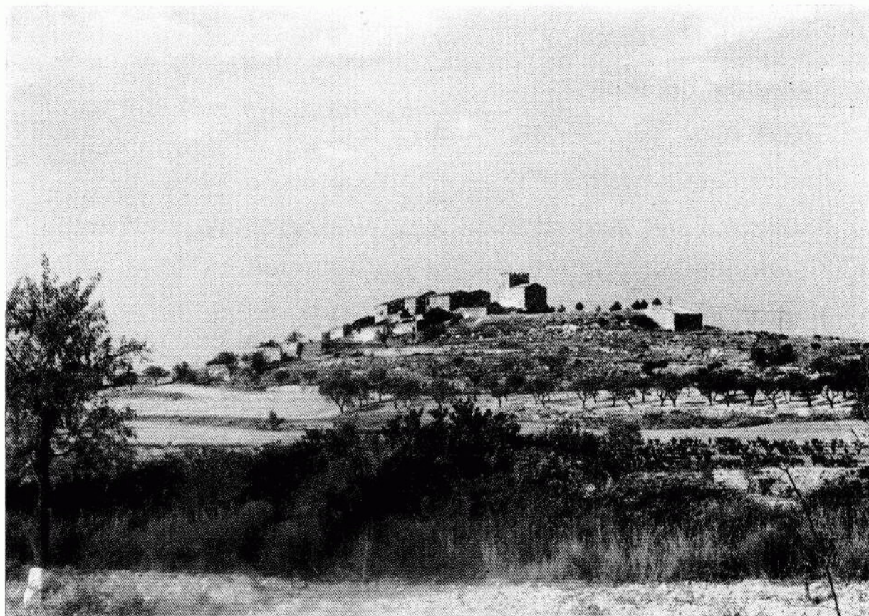
L'agregat de La Pobla de Ferran, aturonat a 705 m d'altitud, 1 km al NO del nucli de Passanant. (Els marlets de la torra són moderns.)
